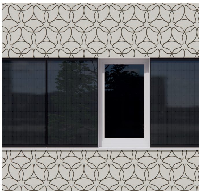
Mischfassade mit vorgefertigten Putzelementen: StoEcoshape
