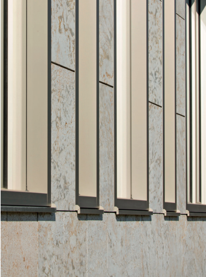
Fensterausbildung der fugenbetonten Natursteinfassade
