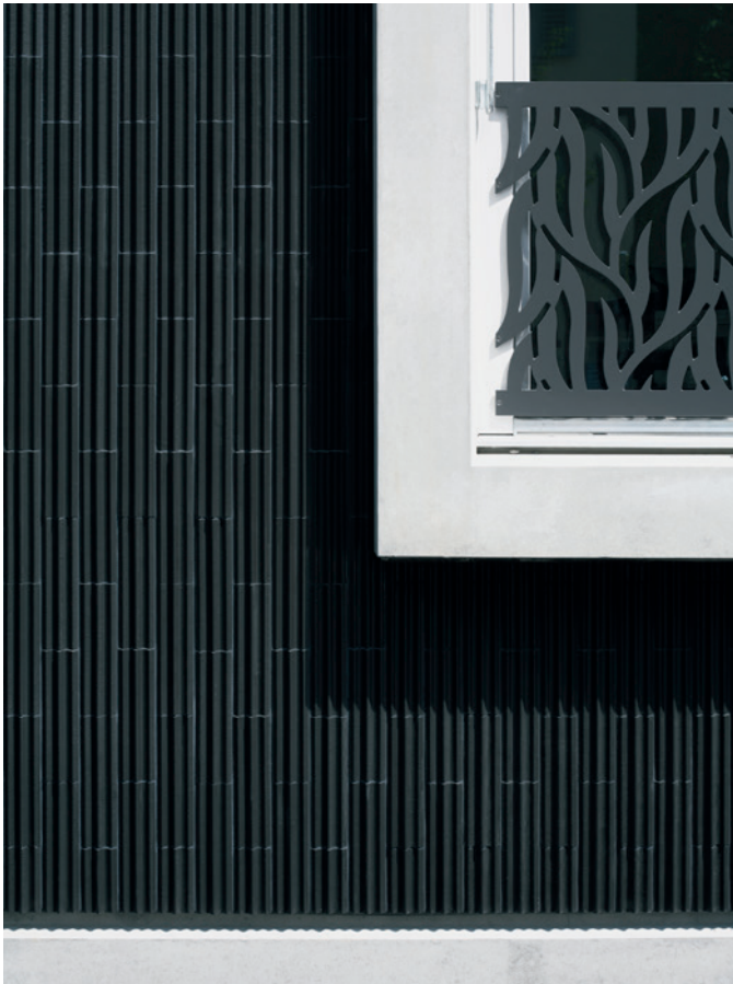
Materialübergang vom Sockel und Fenster zur Keramikfassade
