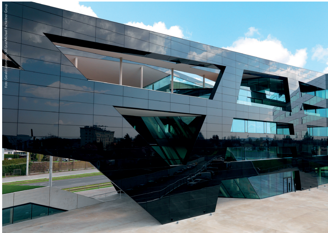
MP09, Graz, Österreich, Architekt: GSarchitects ZT-GmbH
