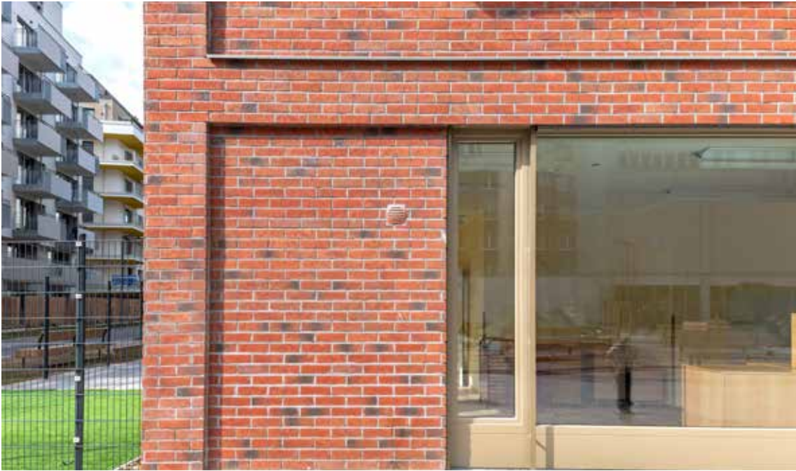
Bild links/unten: Erdberger Lände, Wien, A Architekten: Weichenberger Architects, Wien, A BEHF Corporate Architects, Wien, A Freimüller Söllinger Architekten, Wien, A Produkte: StoBrick, StoTherm Mineral, StoTherm Vario Fotograf: Christian Schellander
